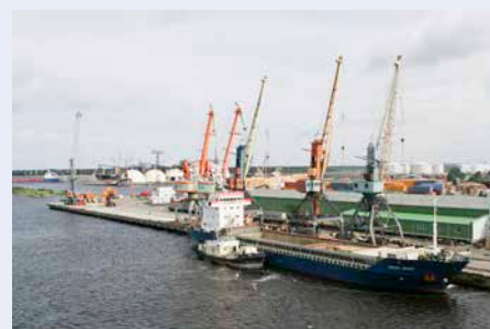
L'ancien commerce pétrolier dans le port industriel letton de Riga (zone de Sarkandaugava) a eu un impact négatif sur l'environnement et les riverains. © SECO
