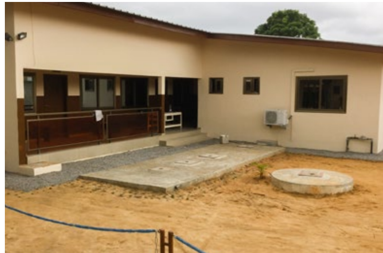
Le « HOPE Center » peu après que les rénovations aient été faites. Photo: BEE160815_HOPECENTER_RENOVATIONS_MS001
