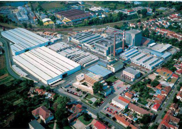
Mitte November wurde der neue Glasschmelzofen in Kyjov vorgestellt. In knapp mehr als drei Monaten Bauarbeit wurden 5.000 Tonnen Spezialkeramik mit 500 Tonnen Stahl verbunden. Der Glasschmelzofen wird weniger Energie als die frühere Schmelze brauchen und signifikant weniger Emissionen erzeugen. Seit Anfang Dezember werden im neuen Schmelzofen jeden Tag 350 Tonnen Glas geschmolzen und in Form von Millionen Flaschen das Werk wieder verlassen.
