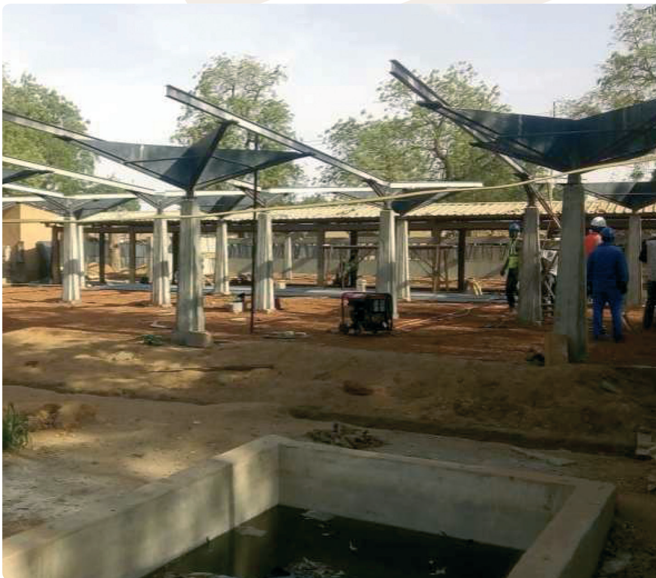
PHOTO : LES ÉTUDES N'ONT DE SENS QUE SI ELLES DÉBOUCHENT SUR DES CONCRÉTISATIONS (CHANTIER DU MARCHÉ DE TÉRA 2019).
