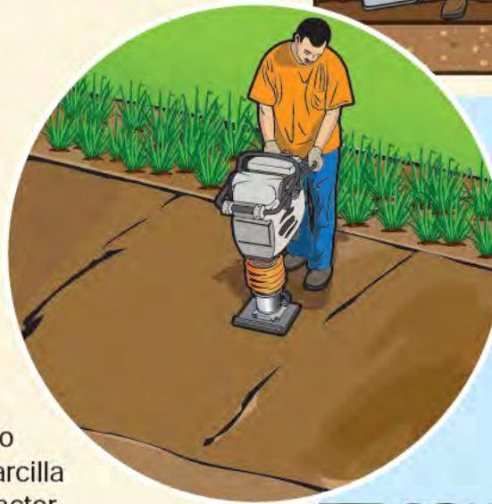
Por esa razón, para reservorios de menor tamaño se aconseja compactar la capa de arcilla en los taludes usando compactadoras manuales.
