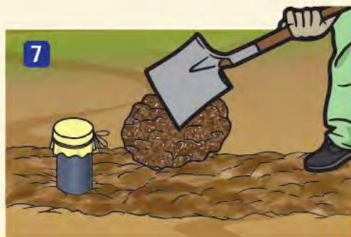
Rellene toda la zanja con arcilla y compáctela con máquina o con apisonadores. Deje unos 30 cm de tubería sobre el suelo.
