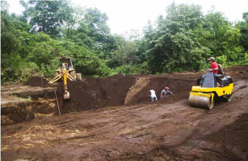
*Reservorio construido solamente por excavación del vaso y conformación de taludes y corona. En estos casos, la tierra removida no se utiliza para conformar taludes. Foto: CATIE.*
