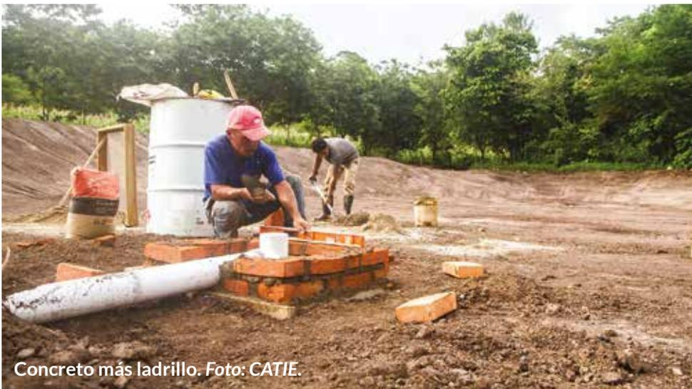
La obra de toma se construye a tres metros de distancia del borde inferior del talud aguas arriba. Se recomienda construir una caja de  $1 \text{ m}^2 \times 0.70 \text{ m}$  de altura. Para darle buena estabilidad, la caja se debe enterrar 30 cm en el piso del vaso.
