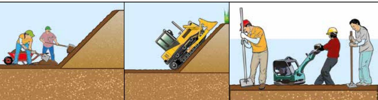
**Figura 2.** Colocación y compactación de arcilla. Fuente: CATIE.
