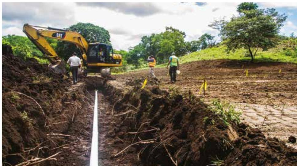
*Compactación de la zanja para cubrir la tubería de agua. Foto: CATIE.*
