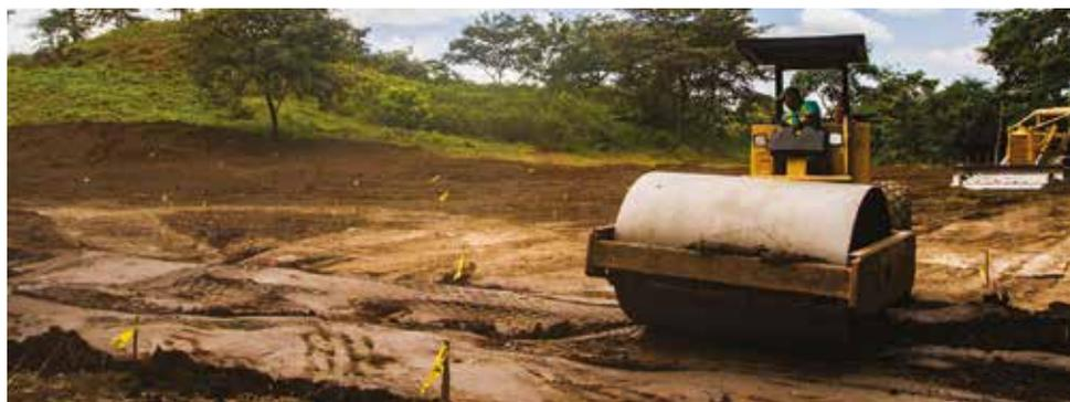
*La compactación del piso y taludes se realiza con cada nueva capa de material colocado en su sitio correspondiente. Recuerde humedecer cada capa antes de compactarla. Foto: CATIE.*
