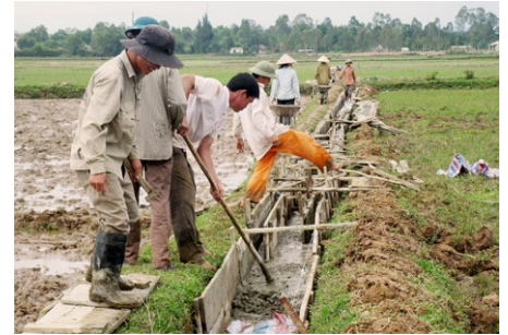
Dorfbewölkerung beim Bau eines eigenen Bewässerungskanals im Rahmen eines Kleinprojekts. © DWC
