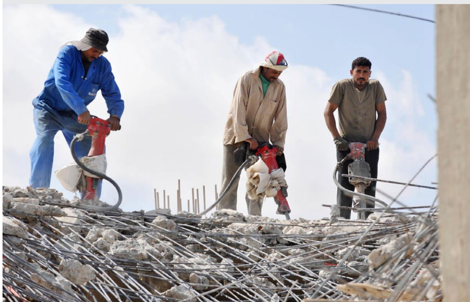
Auf Baustellen – im Bild in Ägypten – arbeiten oft Migranten.
