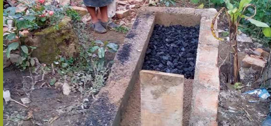
Dos días después de finalizada la construcción del filtro y ya instalados los elementos filtrantes, el biofiltro está listo para usarse.
