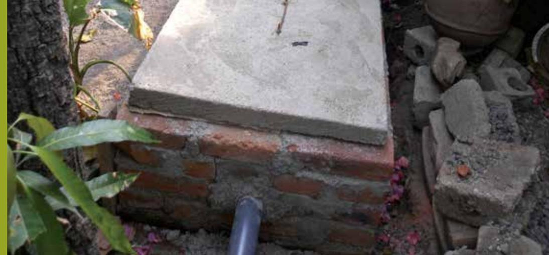
secciones se rellenan con los elementos filtrantes, ahí se retienen los residuos de jabón y grasas.
