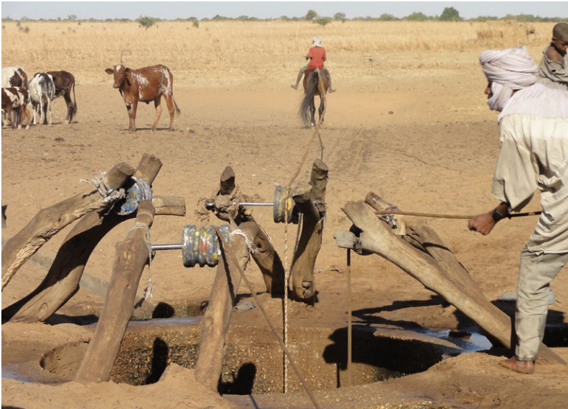
Mit Unterstützung der DEZA werden im Tschad 100 Weidebrunnen gebaut. Das befreit Frauen und Kinder teilweise von der Last des Wasserholens. © DEZA
