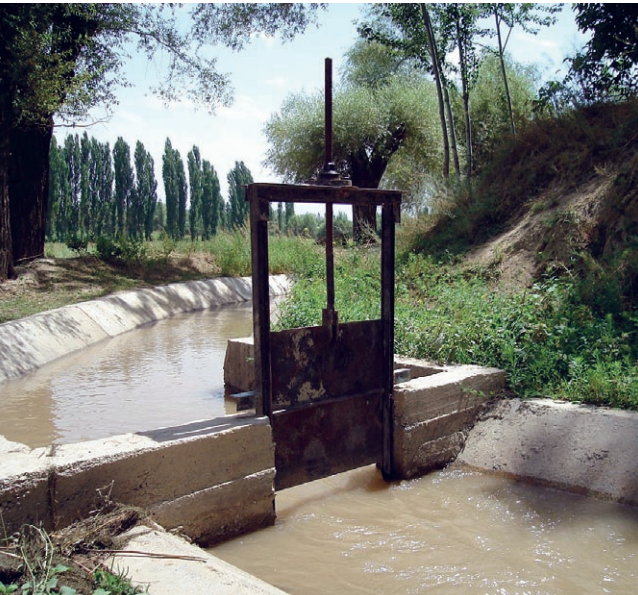
Noch immer wird der grösste Teil der Schleusen im Fergana-Tal von Hand bedient, wie bei diesem Kanal in der Nähe von Osh.
