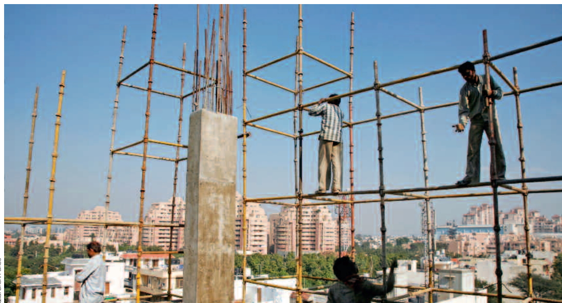
Un chantier de construction à Gurgaon, une ville-satellite de Delhi. En Inde, le boom de la construction pose de sérieux problèmes énergétiques.
