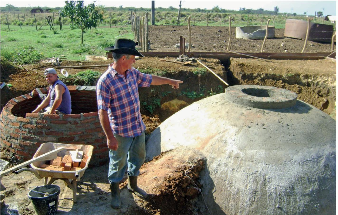
Les installations de biogaz permettent aux paysans cubains d'éliminer le lisier et de générer le gaz nécessaire à leur propre consommation.
