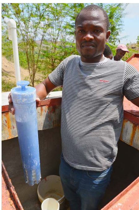
Le traitement de l'eau au chlore est l'une des tâches centrales du comité de gestion de l'eau. Il permet de détruire les bactéries du choléra et d'autres agents infectieux.
