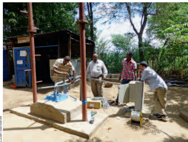
Alcuni tecnici kenyani installano un apparecchio con cui è possibile controllare la falda freatica che si trova sotto il campo profughi di Dadaab. I dati sono inviati in Svizzera tramite una rete di telefonia mobile.
