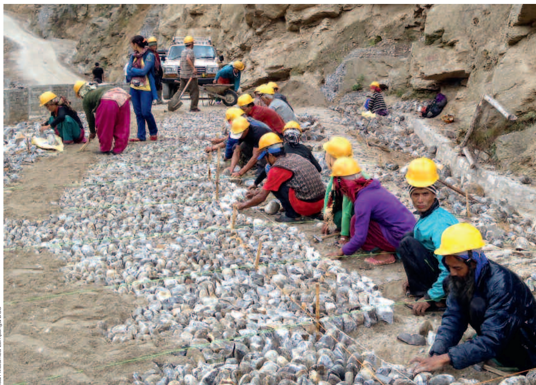
La popolazione locale è coinvolta nella costruzione della strada: partecipa alla pianificazione, lavora con pala e piccone e assume la responsabilità della sua manutenzione.
