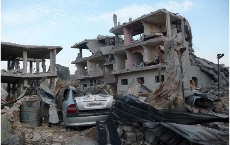
Destructions massives après des combats dans une ville syrienne © Handicap International/Philippe Houliat
