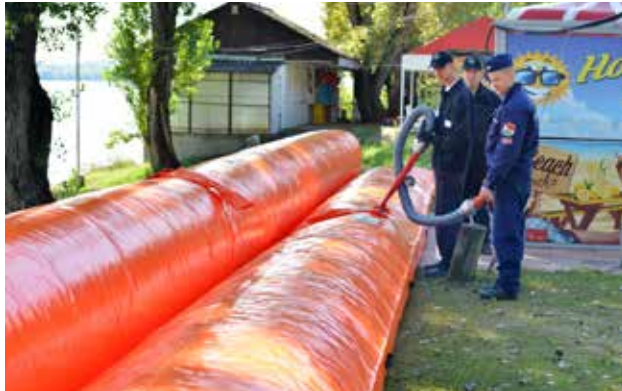
Arbeiter sichern das Ufergelände des ungarischen Flusses Theiss gegen Überschwemmungen ab. © DEZA
