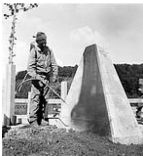
Construction de lignes d'obstacles antichar dans les années 1940. Les dents de dragons édifiées sont surnommées «Toblerones» du fait de la ressemblance des blocs avec le fameux chocolat suisse. © Theo Frey / Archives fédérales suisses, Berne
